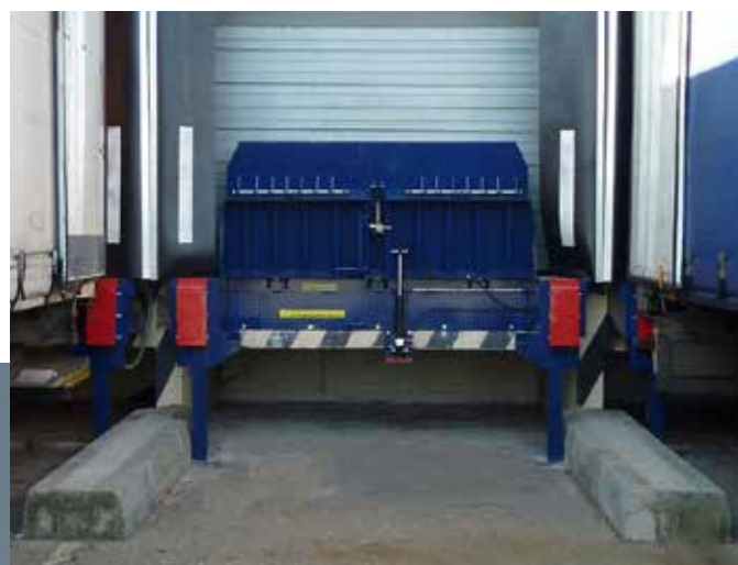
Mini-niveleur STAA en position de travail, lèvre sortie
