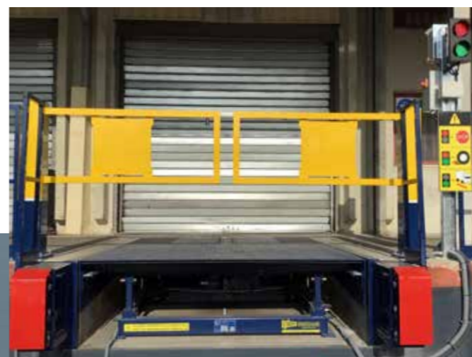
Barrière de quai pivotante avec verrou à gâchette électromagnétique
