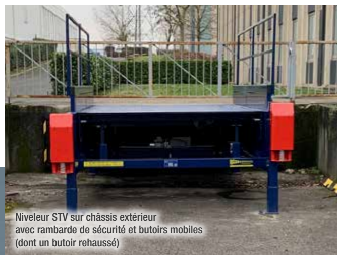
Niveleurs STV sur châssis extérieur avec garde-corps, zone refuge et butoirs mobiles rehaussés
